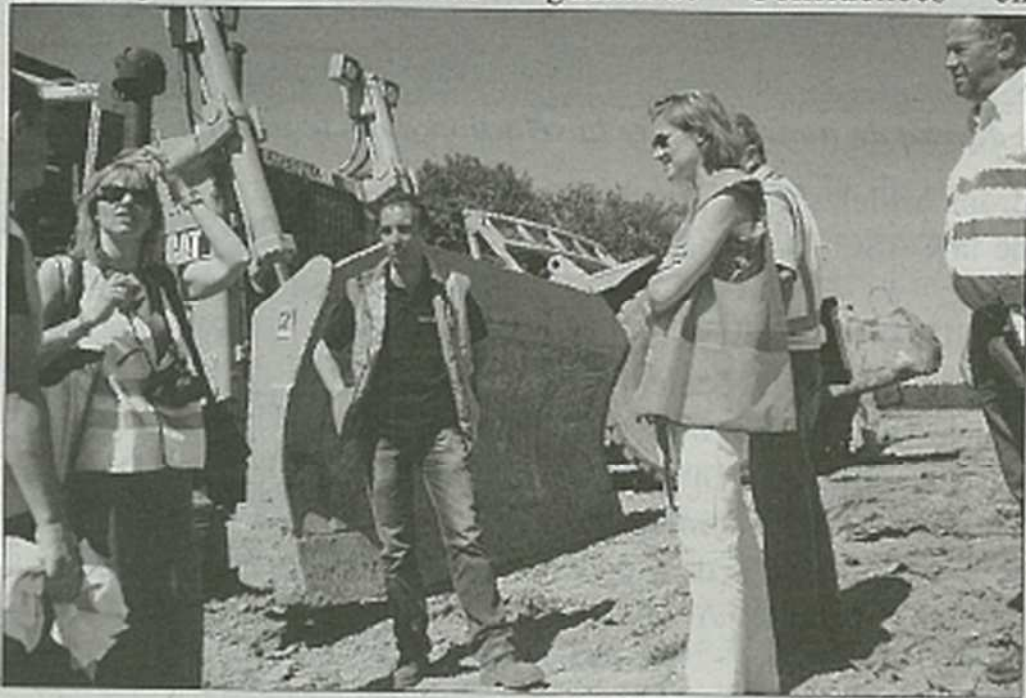
Les engins utilisés sur ce chantier sont impressionnants.
